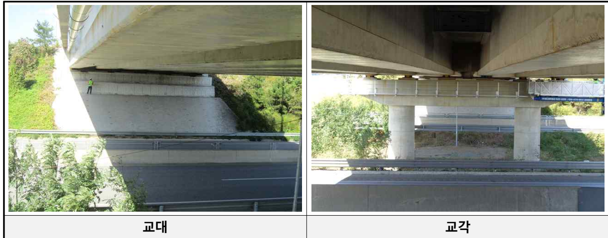
[교대 및 교각 전경]
