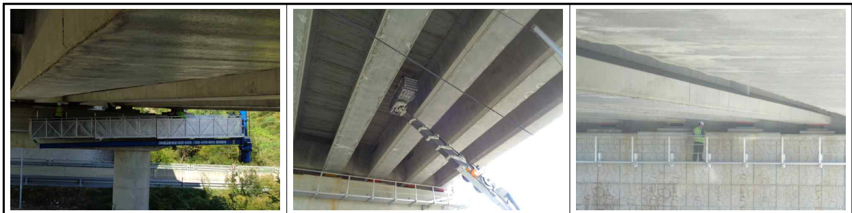
[고소작업차, 굴절점검차를 이용한 근접조사 실시]
